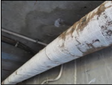
Photo N° 659 ECH-N°2 CALORIFUGEAGE --LOCAL POUBELLE Conduits de fluide Laine minérale + enveloppe plâtrée
